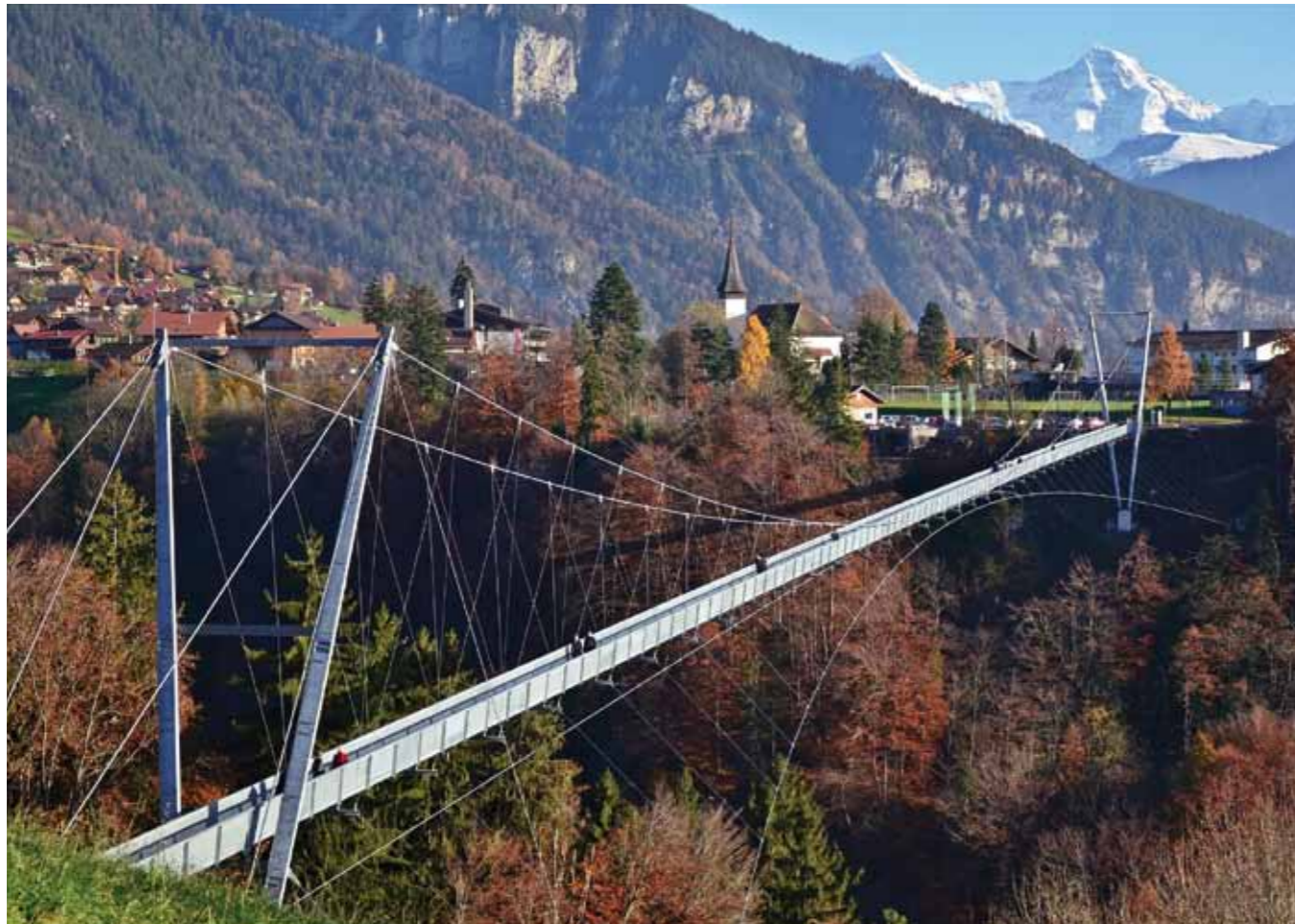
Auftraggebende Verein Panorama Rundweg Thunersee, Thun; Autorenschaft/Planung Theiler Ingenieure AG, Thun; Prüfstatik dsp Ingenieure & Planer AG, Greifensee; Geologie Geotechnisches Institut, Spiez; Vermessung Dütschler & Nägeli AG, Thun; Gestalterische Beratung Beat Gassner, Thun; Baubiologie Roland Luder, Thun; Projektpartner Berner Fachhochschule BFH-AHB, Burgdorf; Fertigstellung 2012; Adresse 3655 Sigriswil am Thunersee
